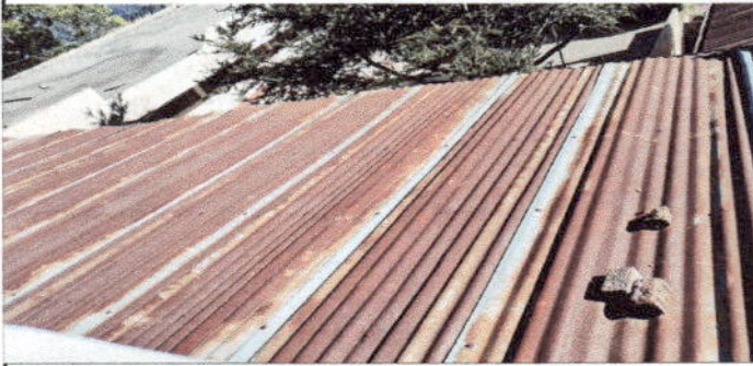
Foto1: Cambio de lamina por lamina troquelada aluzinc calibre 26
