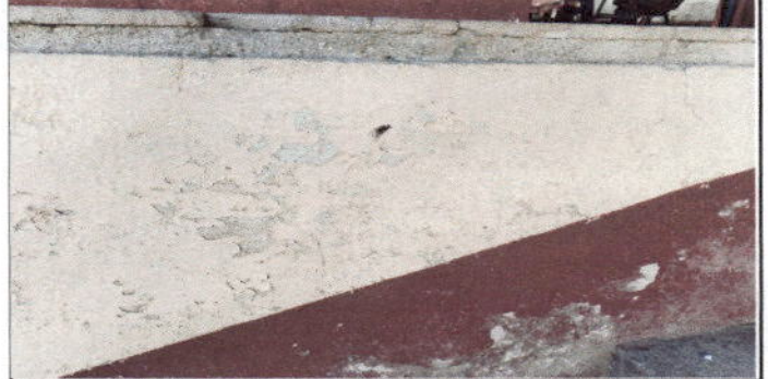
Foto 4: Pintura de muros interiores y exteriores
