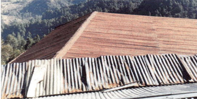
Foto 3: Cambio de lamina por lamina troquelada aluzinc calibre 26
