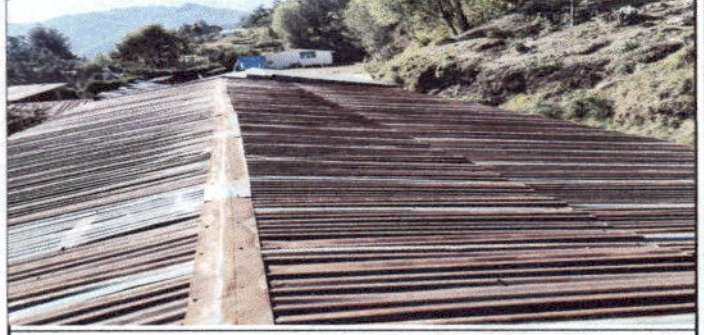
Foto 2: Cambio de Lamina por lamina troquelada aluzinc calibre 26
